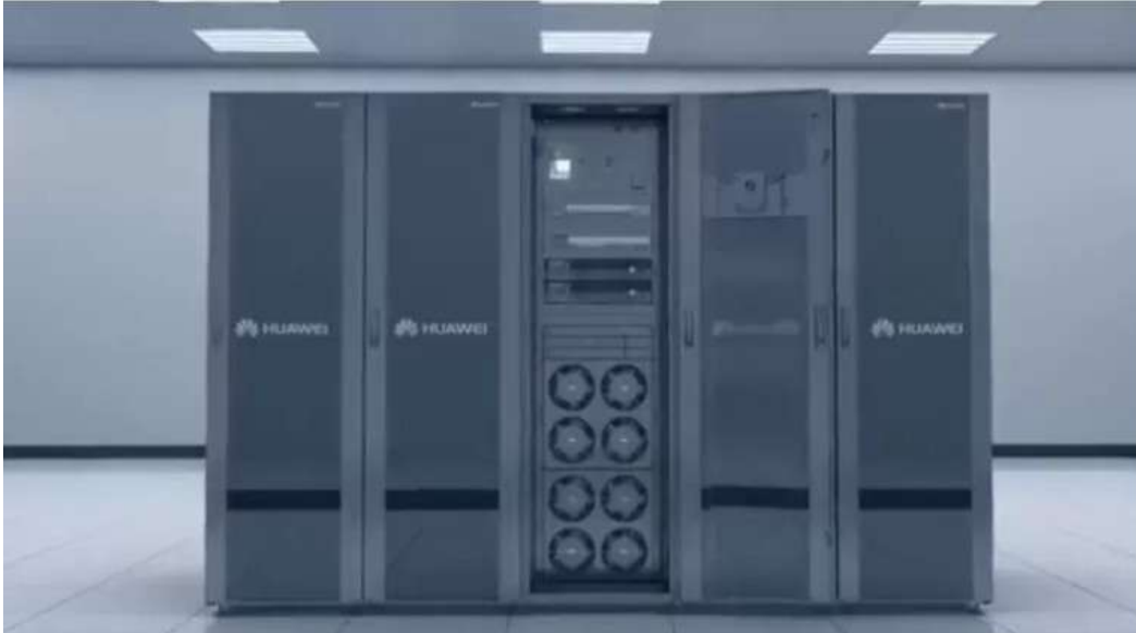
Figura 3 - Fusion Module 800 Huawei
